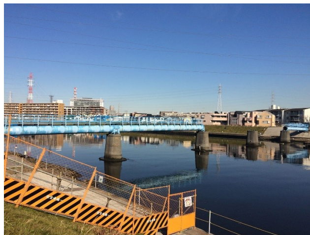
鶴見川水管橋周辺
