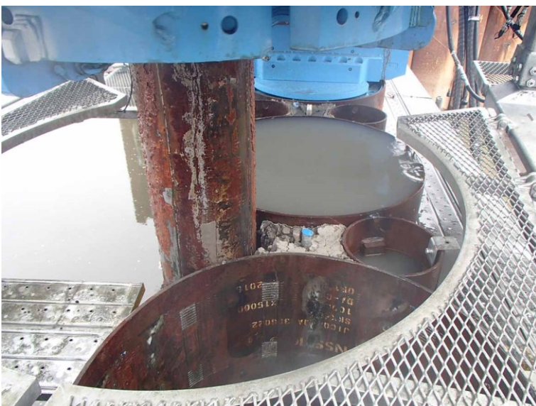
小口径鋼管引抜
