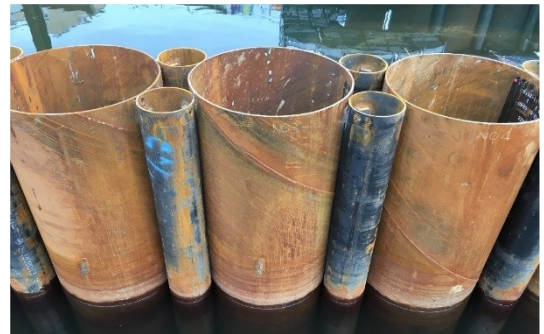
杭間パイプを鋼管杭に沿わせながら回転圧入
