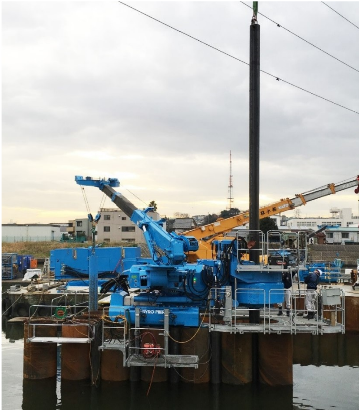
杭間先行掘削後に、鋼管杭を圧入し杭間パイプ把持用チャックアタッチメントを取り付け
