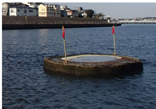
残置された橋脚
