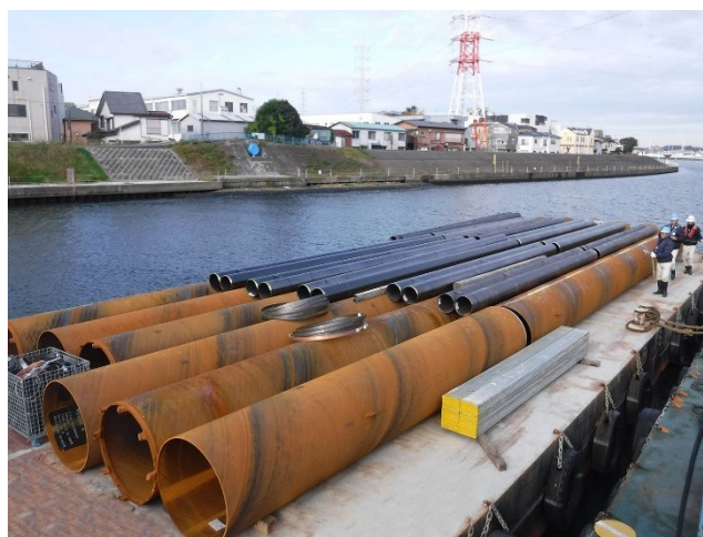
台船で資機材を搬入
