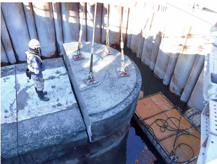
分割し、橋脚を撤去
