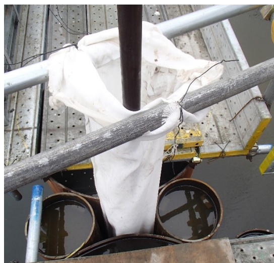
杭間にモルタル充填
