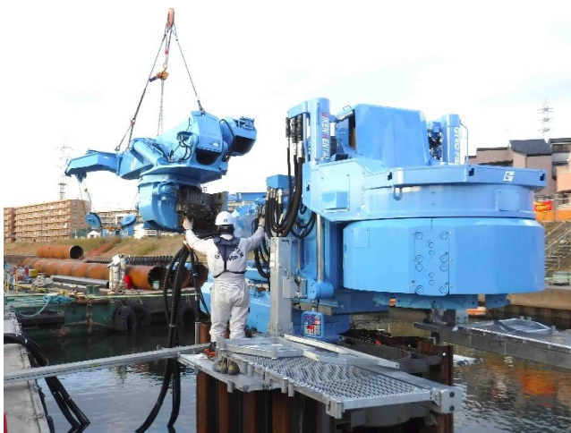
3分割されたパイラーを反力矢板上で組立
