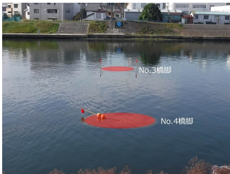
水中に残置された No.3、No.4 橋脚
